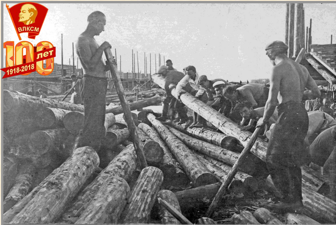
Студенты на строительстве общежития. 20-е годы.
