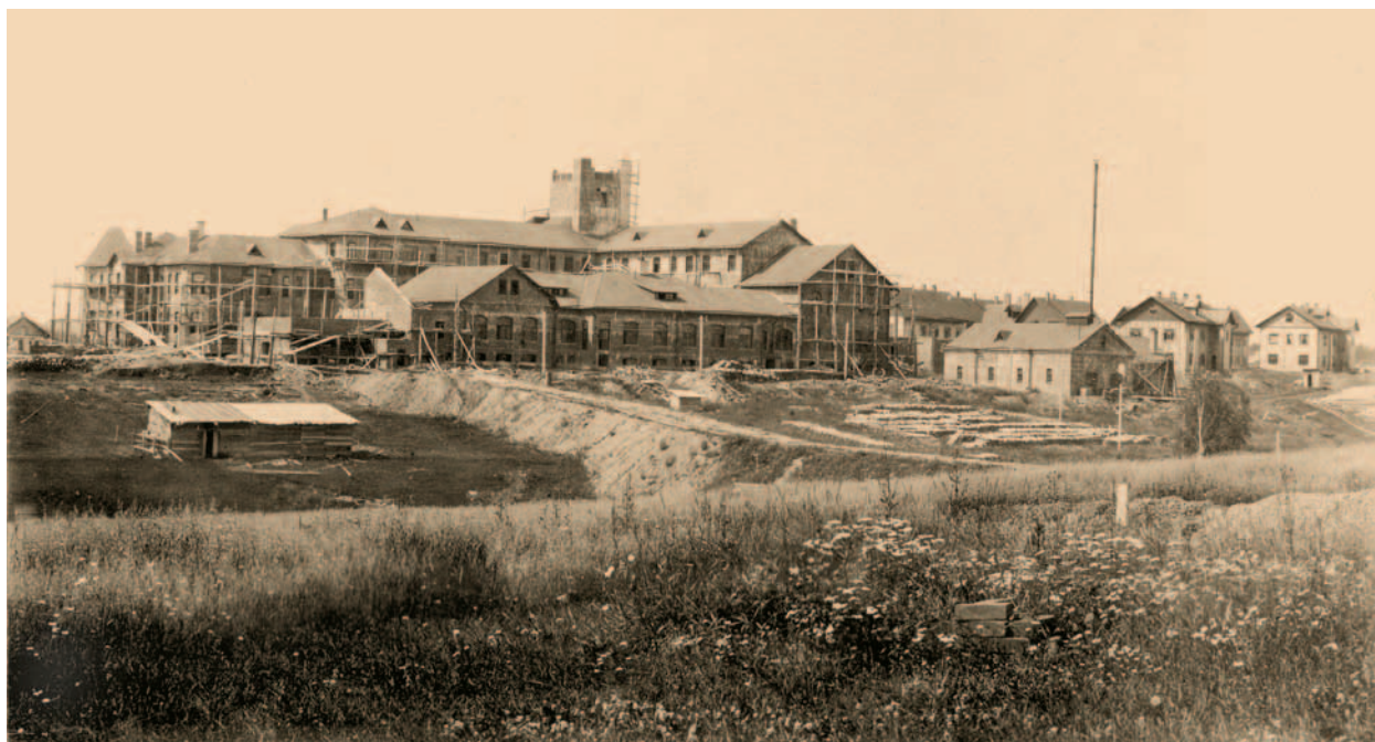
Строительство главного здания и жилых домов
