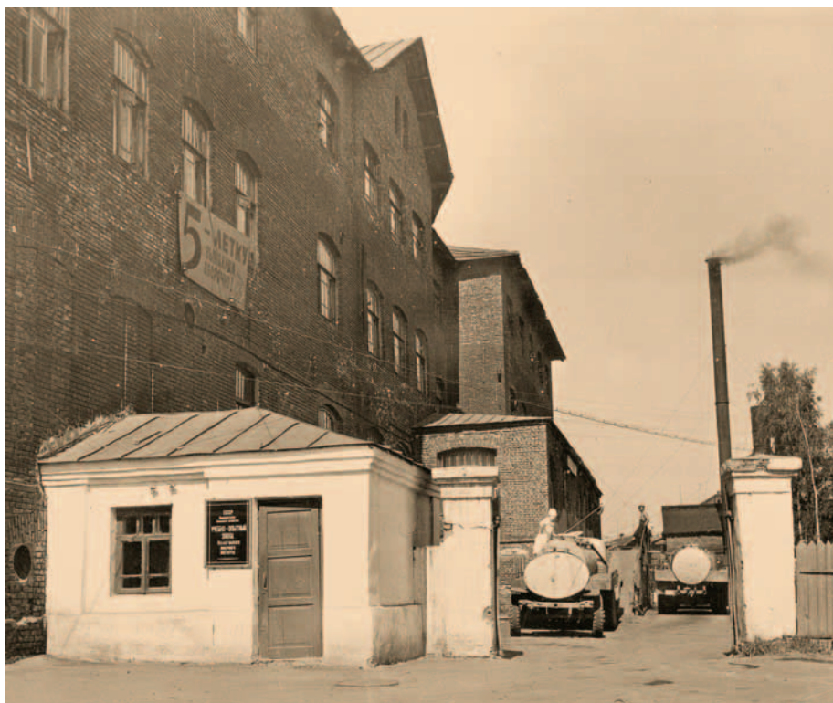
Завод после реконструкции
