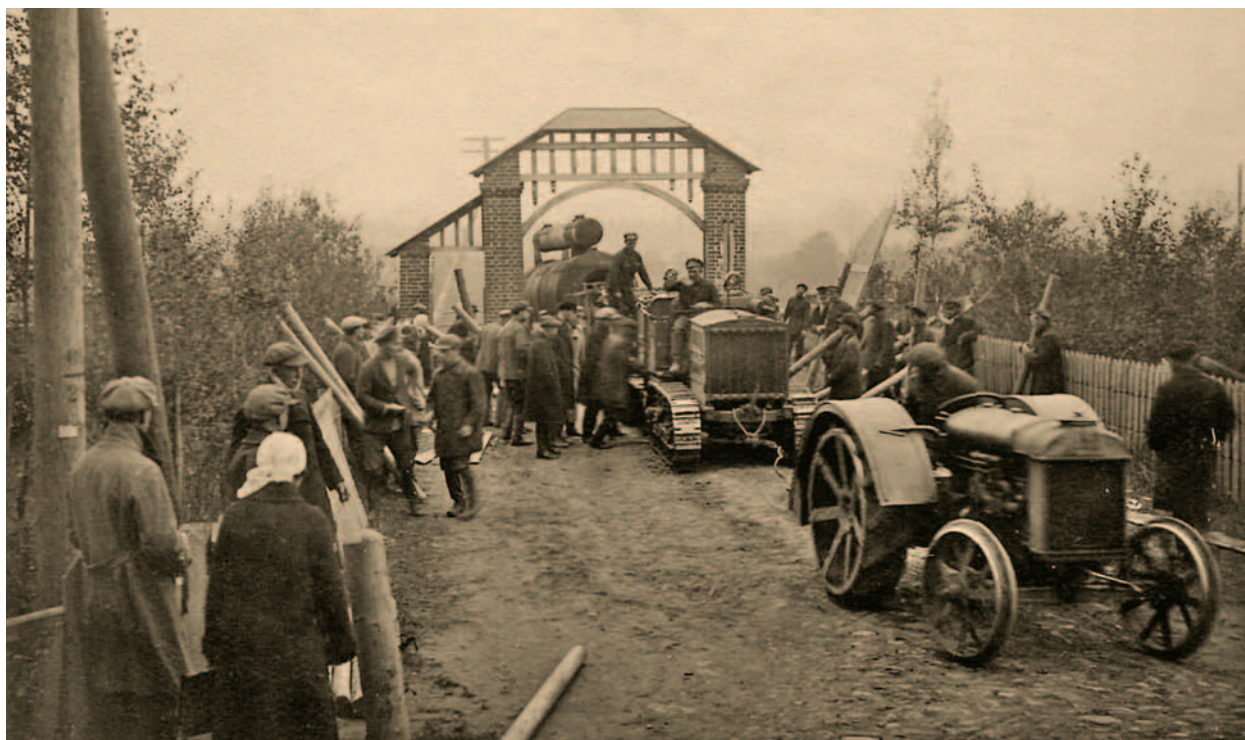
Транспортировка котла для электростанции
