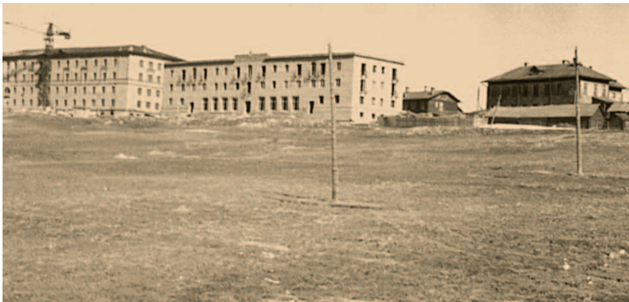
Строительство домов по улице Набережной
