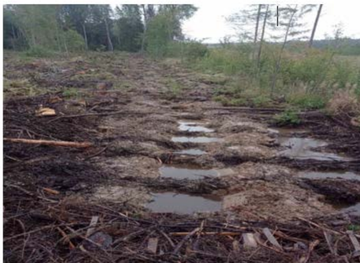
Рис.2. Подготовка почвы экскаватором KOMATSU PC210LC-10M0
